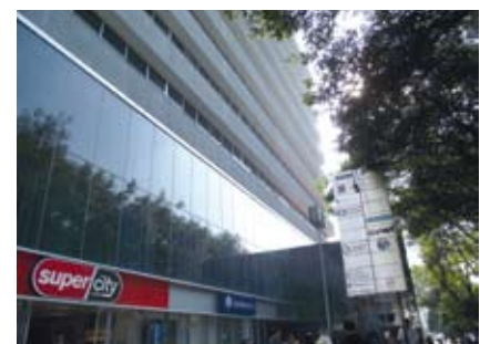
Instalaciones de Konecta en México DF
